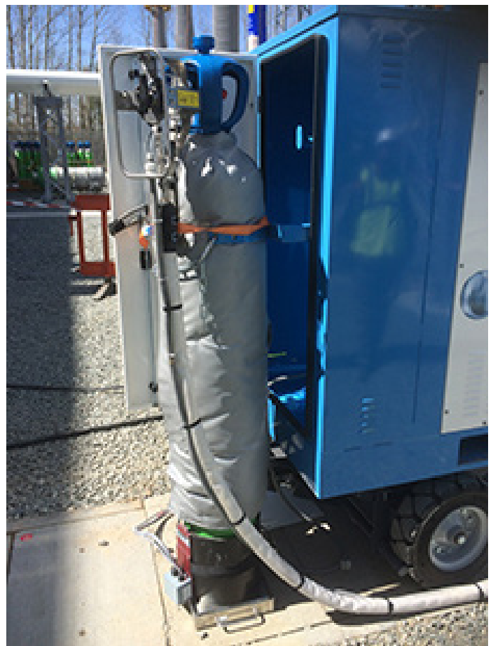
Image 6 : Bouteille de g 3 équipée de son système de chauffe
