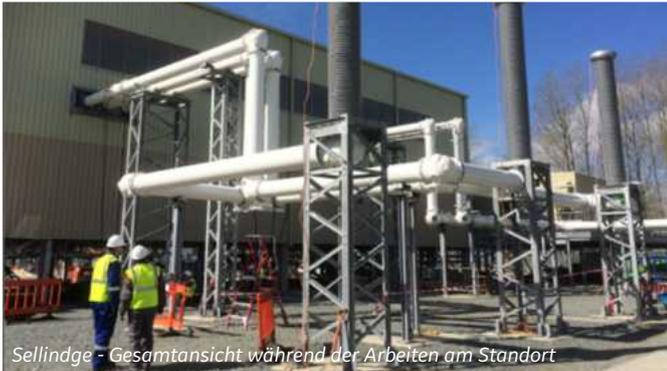
In der Energieübertragungsbranche gibt es Grund zum Feiern: Erstmals wurde bei einer gasisolierten Hochspannungsleitung (GIL) eine recht innovative Alternative zum sonst üblichen SF<sub>6</sub> eingesetzt – das Isoliermedium g<sup>3</sup>. Bis heute gab es keine geeignete Alternative zu der SF<sub>6</sub>-Technologie, die in den 70er-Jahren als Isoliermedium in Hochspannungs-schaltanlagen eingeführt wurde.
